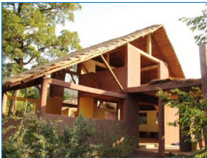
Edificio central de la EBFJ
